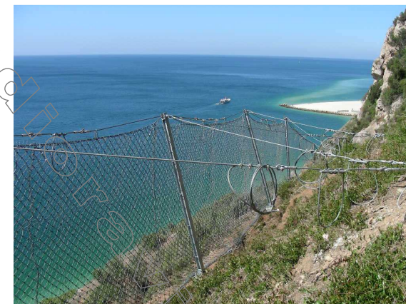
Fig. 1 - Vista generale di una struttura paramassi flessibile a rete
