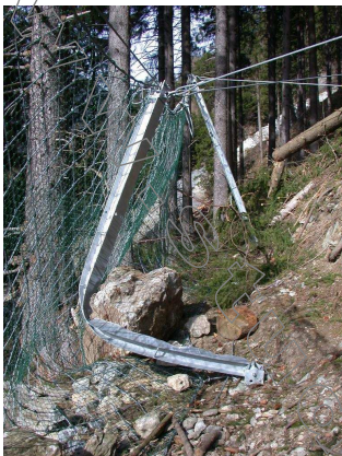
Fig. 12 - Vista dell'effetto dell'impatto di un blocco su un montante e simulazione
